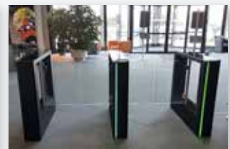
Skall- og sonesikring
