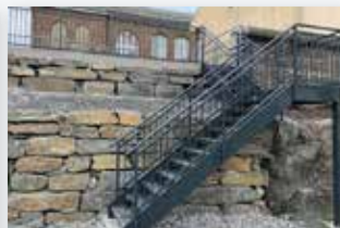
Rekkverk, rister og trapper
