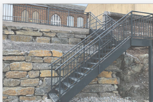
Rekkverk, rister og trapper
