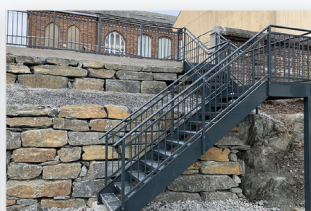
Rekkverk, rister og trapper
