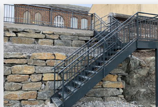
Rekkverk, rister og trapper
