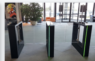
Skall- og sonesikring
