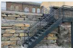
Rekkverk, rister og trapper
