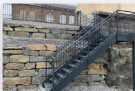
Rekkverk, rister og trapper
