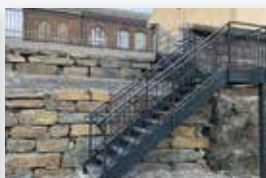
Rekkverk, rister og trapper
