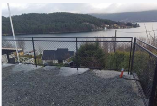
Flettverks rekkverk Robert.
