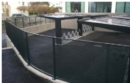
Sykkelparkering lakkert strekkmetall aluminium
