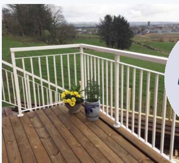
Rekkverk hvitlakkert på terrasse.
